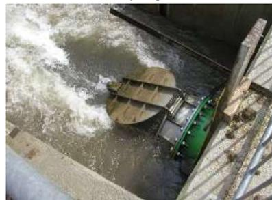
VOCE DI CAPITOLATO : fornitura di valvola a clapet in acciaio ..... ( zincato o rivestito - inox AISI 304 - inox AISI 316 ) a sezione circolare in esecuzione compatta con tenuta su tutta la circonferenza; tenute in EPDM, carico idraulico 3 m H2O; telaio con struttura autoportante per fissaggio ..... ( ad innesto maschio su tubo avente diametro interno Di.....mm – a muro – su flangia con foratura PN 10 o con flangia a richiesta)
