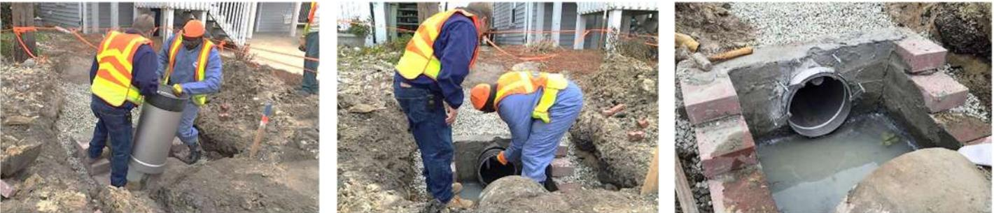
**VOCE DI CAPITOLATO :** Fornitura di valvola antiriflusso in-line serie WS-G in gomma del tipo azionato dal fluido da applicare sulla linea di una condotta avente De ..... mm ; corpo flessibile costruito in un unico pezzo di gomma contenuto all'interno di un guscio in ..... (acciaio inox - PVC - PEAD). Tenuta idraulica 5m H2O. Giunti di accoppiamento valvola-tubo in EPDM con fascette inox
